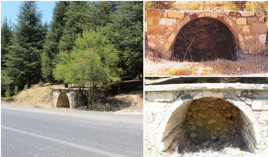
Resim 5: Çapçaklı Çeşmesi'nden genel görünüm
