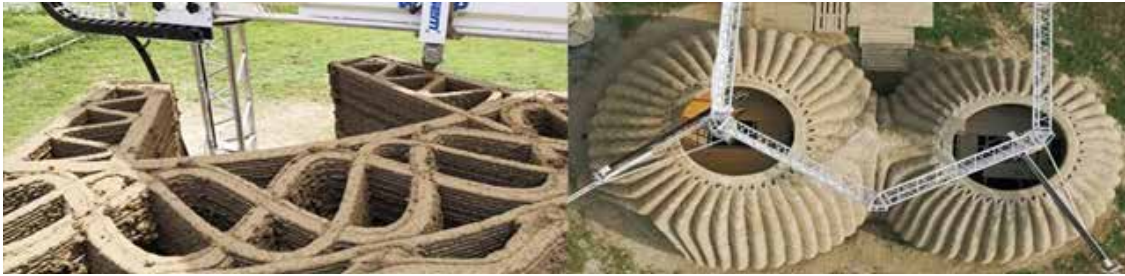
Şekil 5. Tecla, toprak baskılı yapı ve iç mekân tasarımı. (Wasp)
