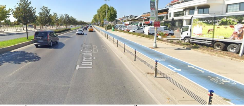
Şekil 2. İstanbul Maltepe Sahil Yolu (Turgut Özal Bulvarı) üzerindeki bisiklet yolu (Google Maps, 2020).
