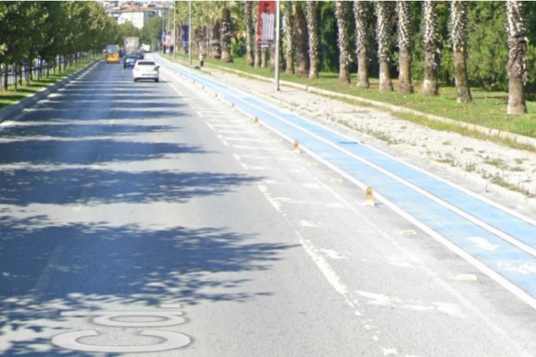
Şekil 3. İstanbul Bakırköy Aksu Caddesi üzerindeki bisiklet yolu (Google Maps, 2020).
