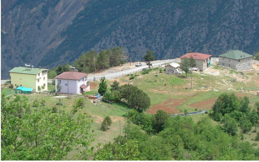
Fotoğraf 7: Yeni Oruçlu Köyünde İnşa Edilen Bazı Çağdaş Konutlar.
