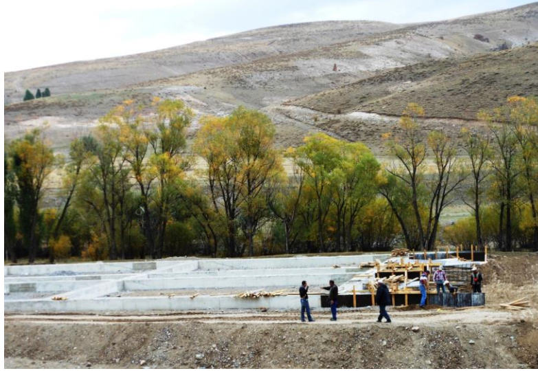
Foto.4. Kurbançayırı Köyü'nde AB projesi kapsamında yapılmakta olan süt sığırı besleme amaçlı ahır ve eklentilerinin inşaatı.
