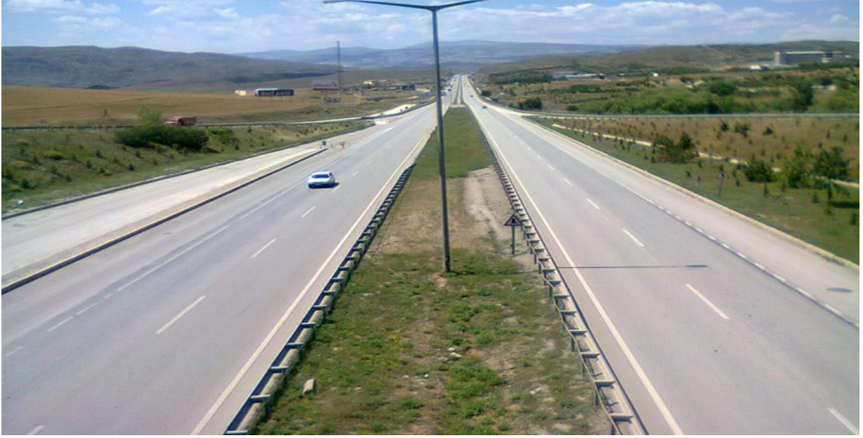
Resim 1. Kaleray Hattı'nın Yapılacağı Orta Boşluk Bölgesi
