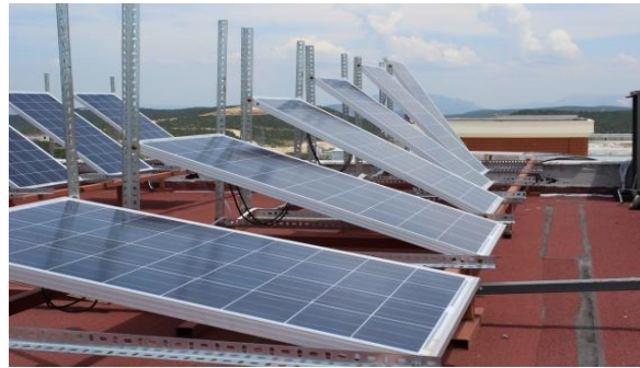
Şekil 1. Farklı eğim açılarındaki FV panellerin kurulumu
