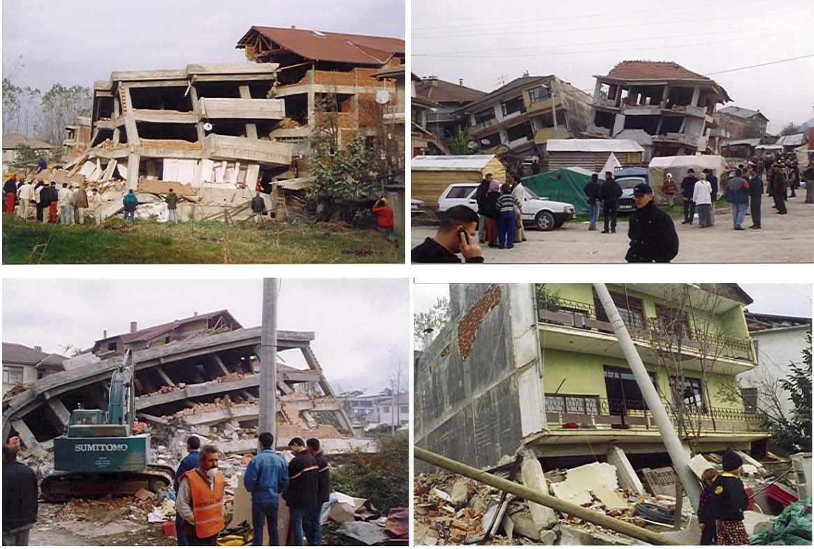
Şekil 9. Yapı zemin rezonans uyumuna göre oluşan Düzce kent merkezinde yapı hasarları [1]
