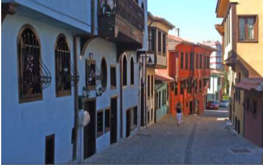
Şekil 2. Sağlıklaştırma çalışmaları sonrasında Kurşunlu Cami Sokak [20]
