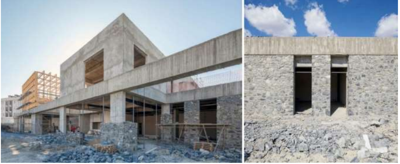
Şekil 3. Beylikdüzü Fatma Ana Cemevi İnşaatı
