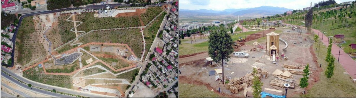
Şekil 5. Araştırma alanı yapım aşaması (Kahramanmaraş Büyükşehir Belediyesi, 2017)
