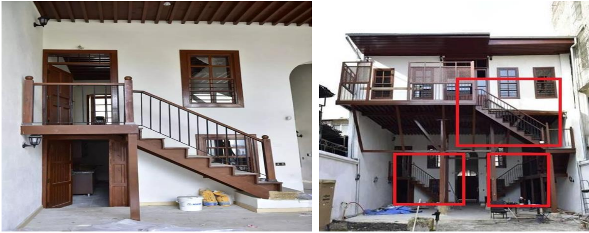
Şekil 10. 152 no.lu Envanter iç bölüm merdiveni yeni hali (KUDEB, 2016)
