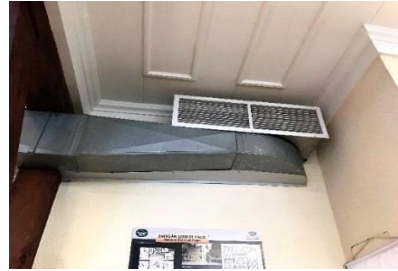
Şekil 35: Bodrum Kat Seminer Odası Hava Kanalı Görünüşü
