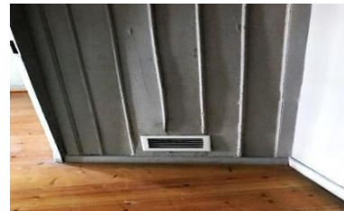
Şekil 39: Zemin Kat İç Mekan Kanal Çıkışı
