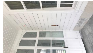
Şekil 37: Zemin Kat Kanal Çıkışı
