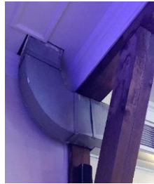
Şekil 34: Bodrum Kat Seminer Odası Hava Kanalı Görünüşü
