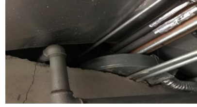
Şekil 43: Tesisat Odası Havalandırma Kanalı Çıkışları
