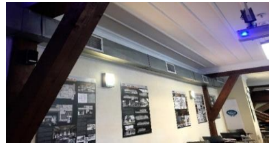
Şekil 33: Bodrum Kat Seminer Odası Hava Kanalı Görünüşü
