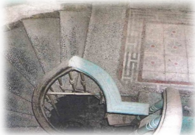
Fotoęraf 21: Merdiven sahanlıęı dřemesi
