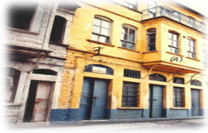
Fotoğraf 38: Eski Hapishane Binası (A) (Ankara Bölge Koruma Kurulu Arşivi)
