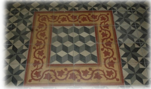
Fotoğraf 12: 1. Kat koridor döşemesi
