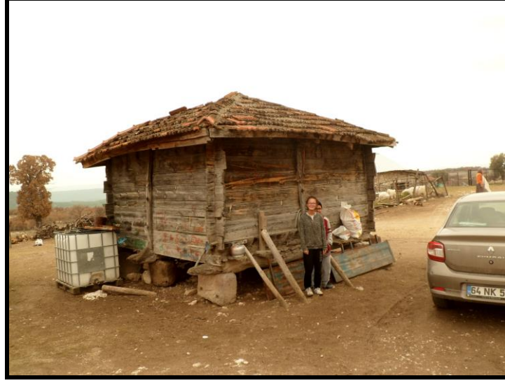
Fotoğraf 5: Piramit çatılı meydan ambarı (Mollamusa köyü Karaçorlar mahallesi- Uşak Merkez ilçesi)
