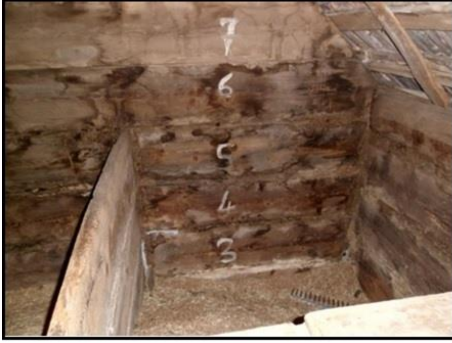
Fotoğraf 7: Meydan ambarı içinden görünüm. Ambarlar içinde ahşap malzeme ile ayrılmış bölmeler bulunmaktadır.
