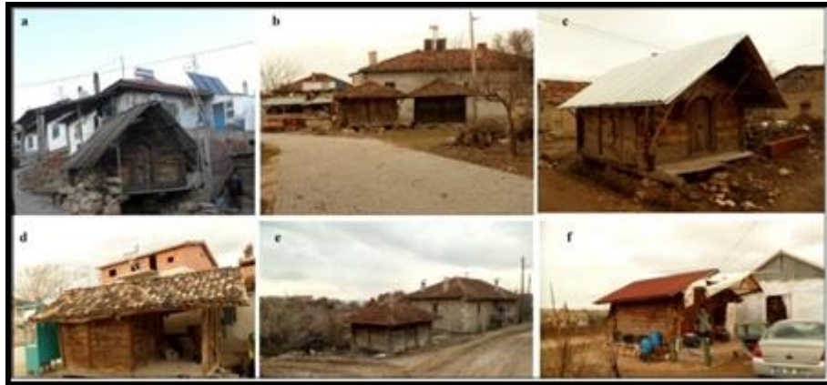
Fotoğraf 6: Ambarlarda çatı şekilleri ve örtü malzemeleri farklılık gösterir. a-Ahşap malzeme ile örtülü ambar (Ayrancı Köyü-Banaz), b- Oluklu ve Marsilya kiremitleri ile örtülü piramit tipi çatıya sahip meydan ambarları (Mollamusa Köyü Hacınasif Mahallesi-Uşak Merkez İlçesi), c-Sacla örtülü çatıya sahip ambar (Kalfa Köyü-Uşak Merkez İlçesi), d-Kapı girişinde saçakları uzatılmış balkona sahip ambar (Akbulak Köyü-Uşak Merkez İlçesi), e- Piramit tipi çatıya sahip ambar (Ormandamı Köyü-Uşak Merkez İlçesi), f-Çağdaş örtü malzemesi ile kaplı ambar (Kökez Köyü).
