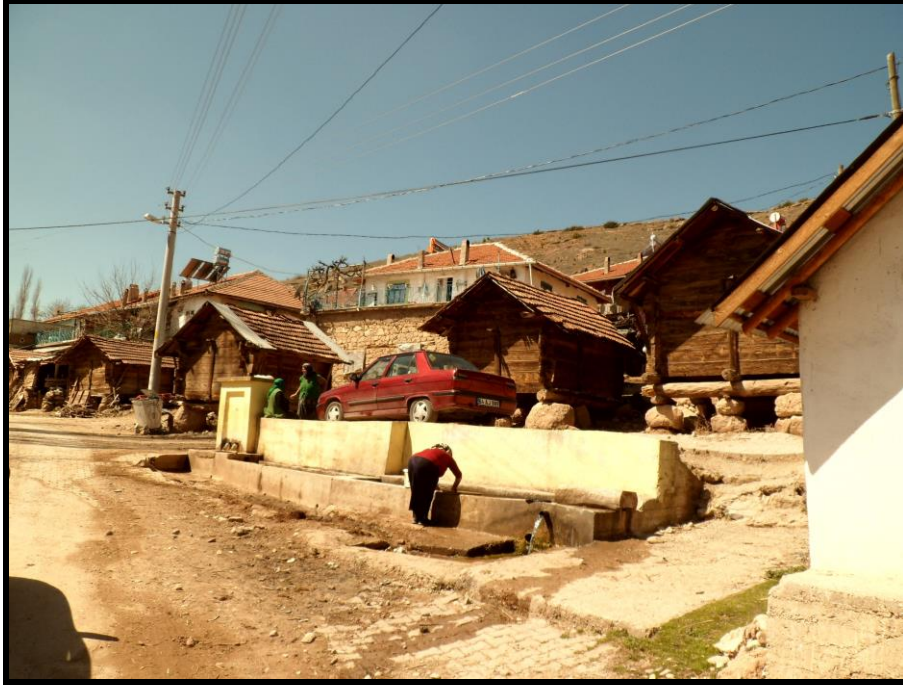
Fotoğraf 2: Büyük taş bloklar üzerinde inşa edilmiş meydan ambarları (Gürlek Köyü-Banaz)
