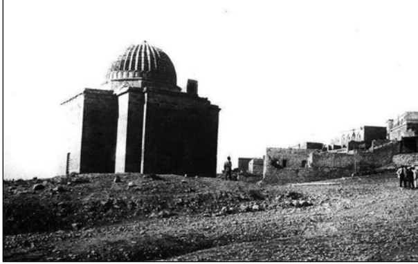
Foto. 2 Hamza-i Kebir Camii Genel Görünüşü (G. Bell-1911)
