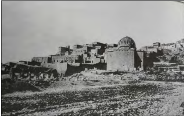
Foto. 3 Hamza-i Kebir Camii Doğu Cephe Görünüşü (G. Bell-1911)
