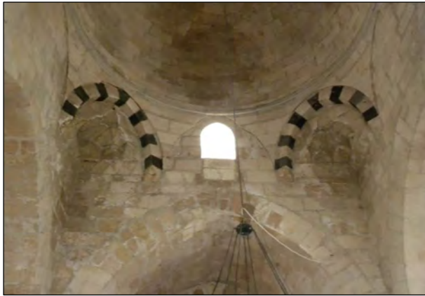
Foto. 12 Hamza-i Kebir Camii tromp detayı
