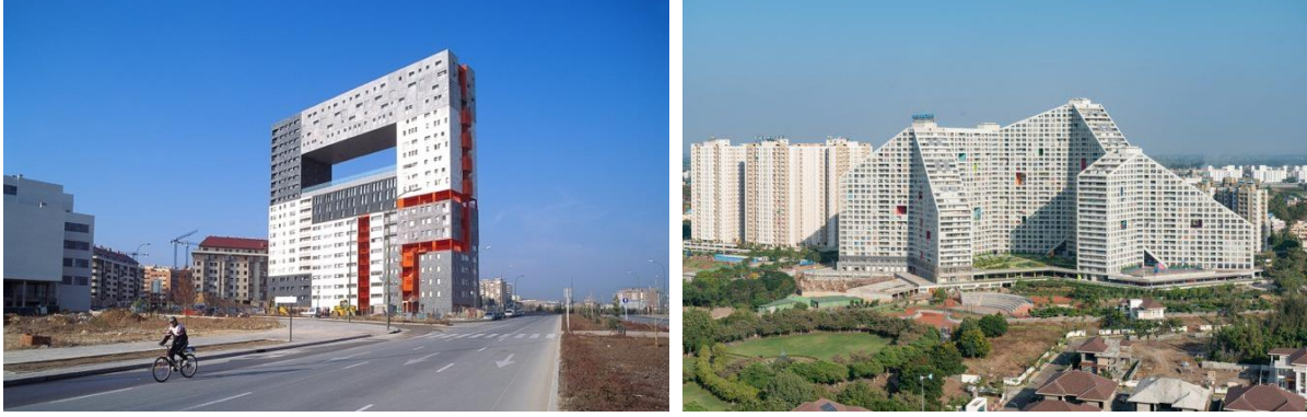
Şekil 1. Sol: Mirador Housing Project (MVRDV); Sağ: Future Towers (Arkitektüel)
