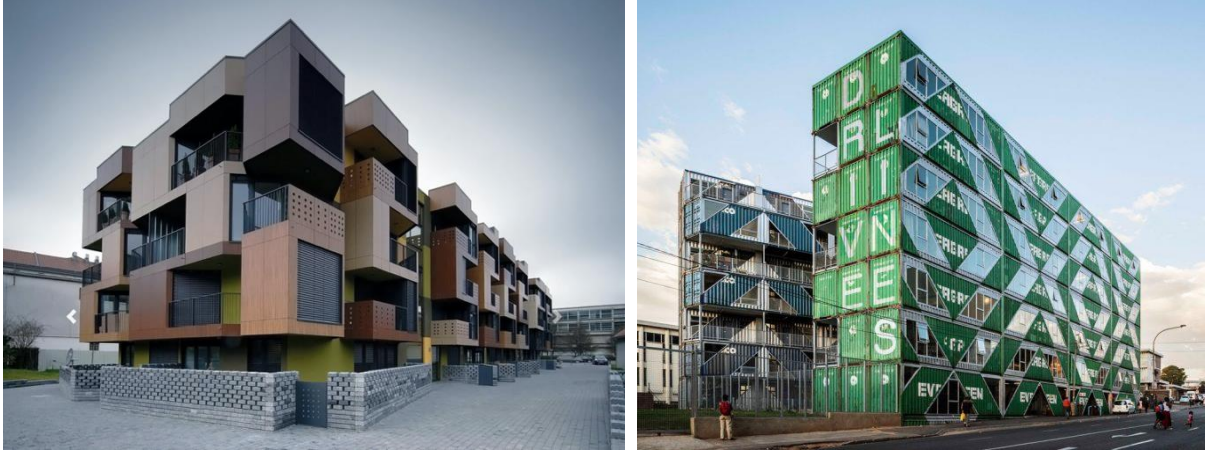
Şekil 5. Sol: Tetris Apartments (Archdaily, 2008); Sağ: Drivelines Stüdyoları (Arkitektüel)
