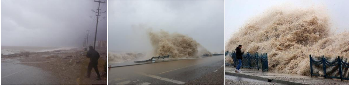
Şekil 6. Fırtınalı dönemlerde dalga ile Antalya-Kemer yoluna plaj malzemesinin taşınması ve korkulukların hasar görmesi (2014).
