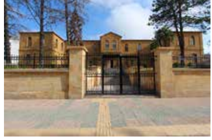
Foto. 38. Yozgat Lisesi Güney Cephe 1. (2017)
