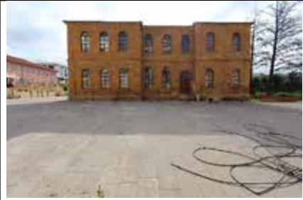
Foto. 42. Yozgat Lisesi Doğu Cephe (2017)
