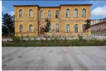
Foto. 41. Yozgat Lisesi Batı Cephe (2017)
