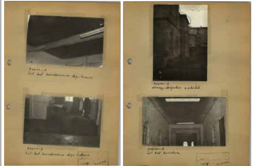
Foto. 3. Yozgat Lisesi Orijinal Tavan ve Taban Döşemeleri (Kayseri KVKK, Dosya no:66.00.04 Dosya)
