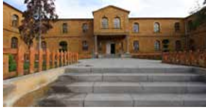
Foto. 39. Yozgat Lisesi Güney Cephe 2. (2017)
