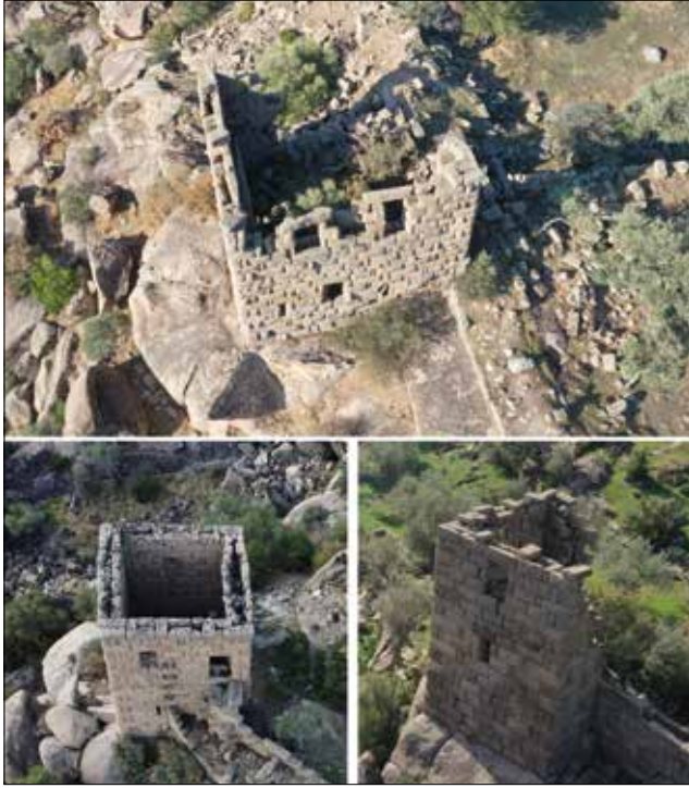
Figür 14: Herakleia'da çift köşe bağı sisteminin uygulanışı / Double corner bond system in Herakleia.
