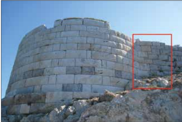
Figür 9: Hellenistik Dönem'e tarihlendirilen yuvarlak kule ile MÖ 4. yüzyıla tarihlendirilen sur bedeninin birleşimi / The combination of the round tower dated to the Hellenistic Period and the city wall dated to the 4th century BC.
