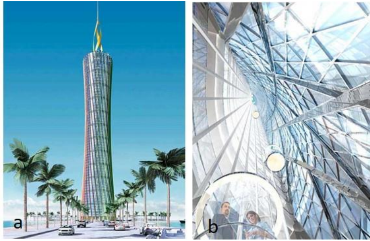
Şekil 16. Butj Al Taqa (a) Bina görünüşü; (b) Bina atriyum görünüşü (Kaynak: (a) Inhabitat, 2007; (b) Inhabitat, 2007).
