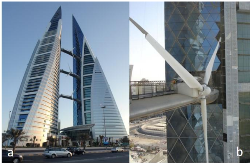
Şekil 4. Bahreyn Dünya Ticaret Merkezi (a) Bahreyn Dünya Ticaret Merkezi genel görünüşü; (b) Rüzgâr türbini görünüşü (Kaynak: (a) Adach, 2009; (b) Adach, 2009).
