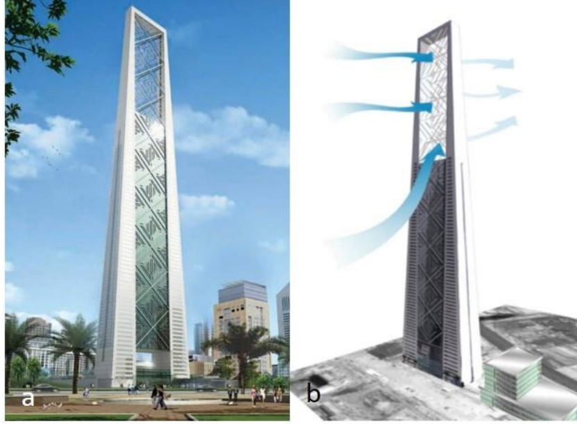
Şekil 12. Lighthouse Kulesi (a) Bina görünüşü; (b) Rüzgâr türbini-rüzgâr etkileşimi ( Kaynak: (a) Skyscrapercenter, 2022; (b) Skyscrapercenter, 2022).
