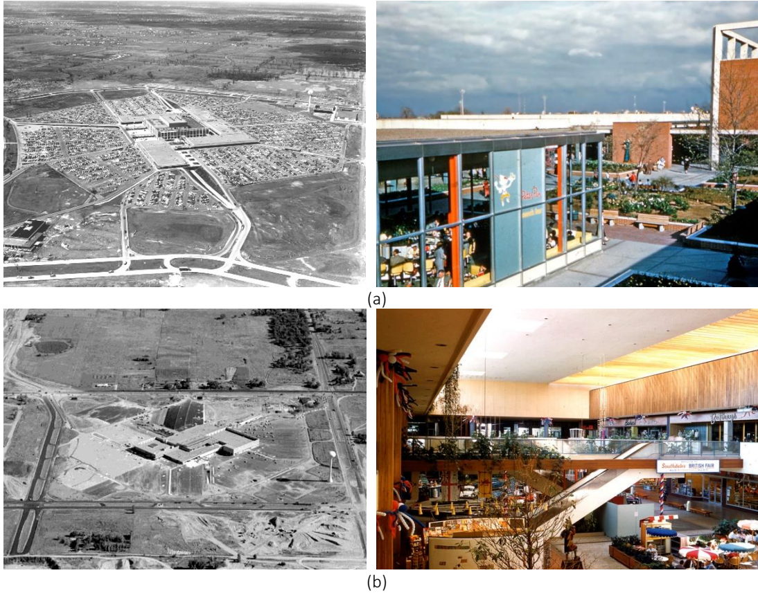
Şekil 7. a) Northland alışveriş merkezi, Southfield, Detroit, 1954 (URL-5); b) Southdale alışveriş merkezi, Edina, Minnesota, 1956, (URL-6)
