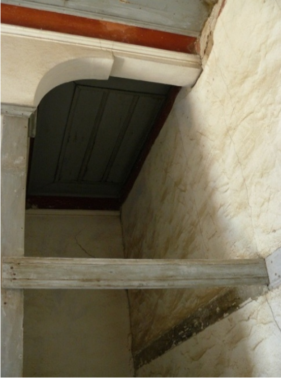
Foto. 7: 1923 yılında yapılan üst katta kuzey-güney yönde uzanan koridoru ikiye bölen bağdadî duvarın doğu yönü.
