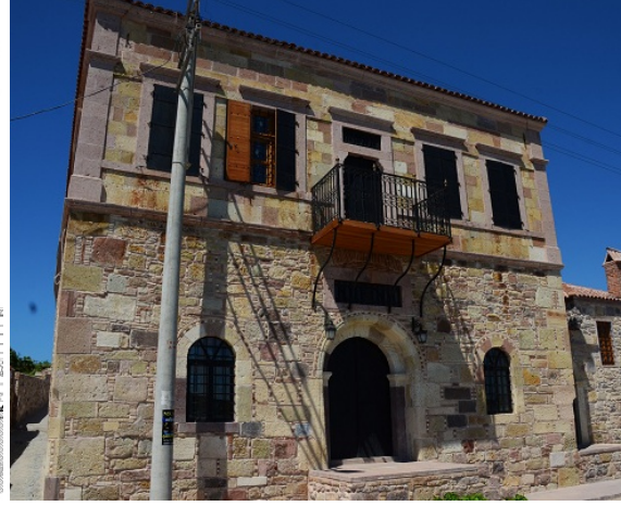
Foto. 9: Restorasyon sonrası, batı cepheden gösterengörünü (Dikili Belediyesi)
