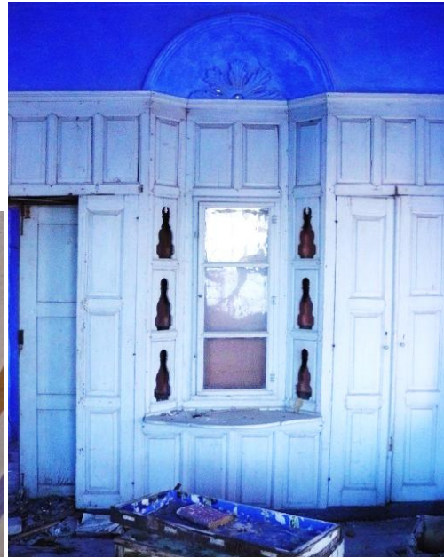
Foto.6: 1.kat kuzeydoğu odası yüklük.
