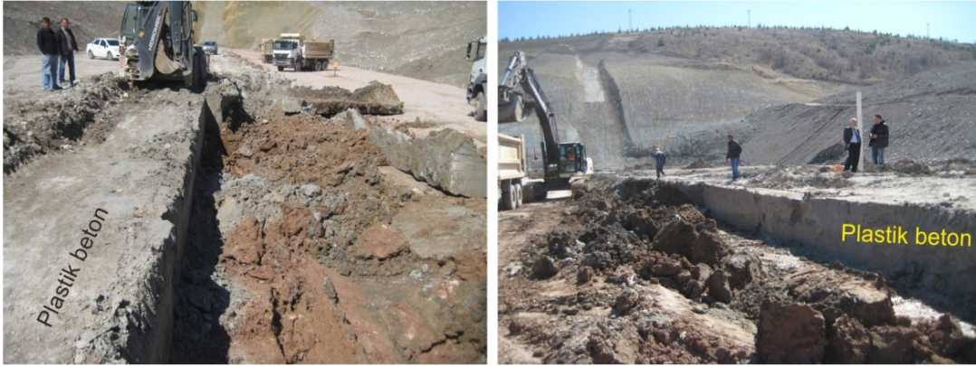
Şekil 5. Plastik beton perdenin üst kısmının tıraşlanarak düzeltilmek üzere açığa çıkarılması (Foto: A.Apaydın).
