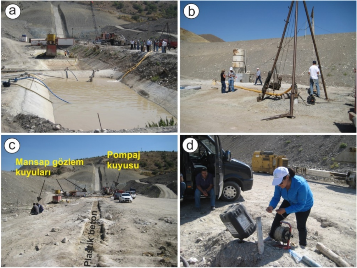
Şekil 3. Bir barajda kil çekirdek altında kalacak plastik beton perdenin geçirimsizlik performansında pompalama testi (Menba taraftaki pompaj kuyusundan (a) çekilen suyun beton çamur havuzuna boşaltılması, mansaptaki gözlem kuyularının perde ve pompaj kuyusuna göre konumu (c) ve gözlem kuyusunda düdüklümetre ile su seviye ölçümü (d) (Foto: A.Apaydın).
