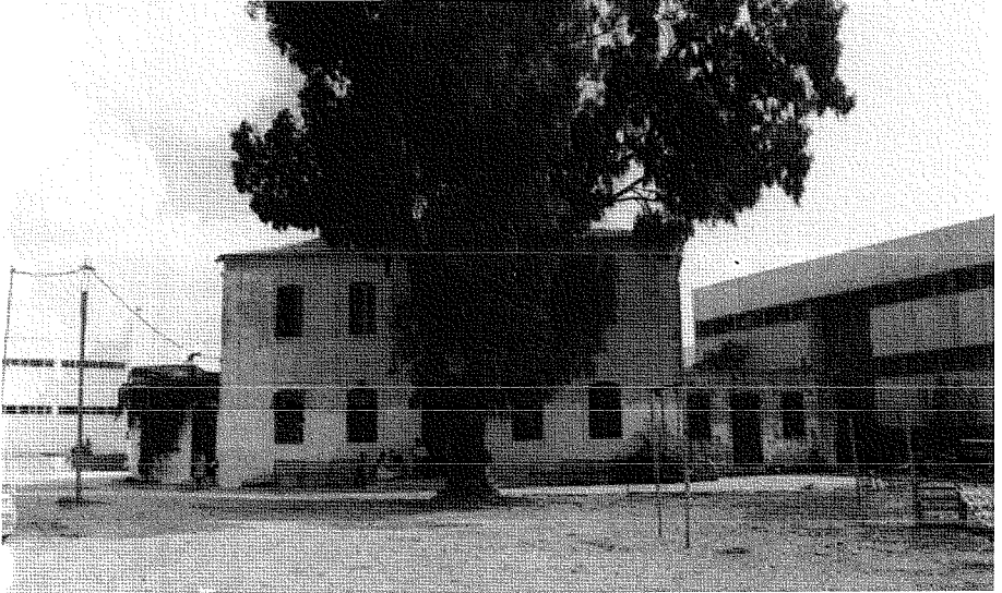
14. Mevlevihânenin şimdiki hali. Sağda mescit, solda türbe kısımları da yerlerinde duruyor. Giriş kapısı önündeki turunc yıllar içinde büyüyüp serpilmiş. (Bir önceki fotoğrafa bak)
