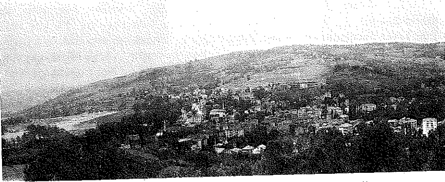
Fotoğraf 5: Gökçebey, yukarı Filyos çayı havzasında ve Filyos çayının kuzeyinde kurulmuş bir yerleşmedir. İçinden geçen Ağustu deresinin sık sık taşması, yerleşmenin en önemli sorunudur. Eski binalar ile yeni binaların yan yana yer aldığı bu yerleşme, inceleme sahasında gelişmekte olan kasabalara örnek oluşturmaktadır (Fotoğraf batıya doğru çekilmiştir).
