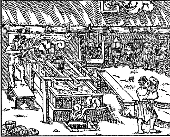
Şekil 2: Tuz üretiminde bir diğer teknik salamuranın kaynatılarak içindeki suyun buharlaştırılması ve tuzun kristallenmesinin sağlanmasıdır. Bu yöntemle sürekli üretim yapmak mümkündür ( www.eu-salt.com/teacher/frame.html ).
