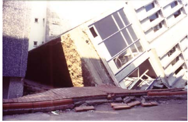
Şekil 4- 17 Ağustos 1999 depreminde Adapazarı'nda sıvılaşma ile hasar gören yapılarda bazıları.
