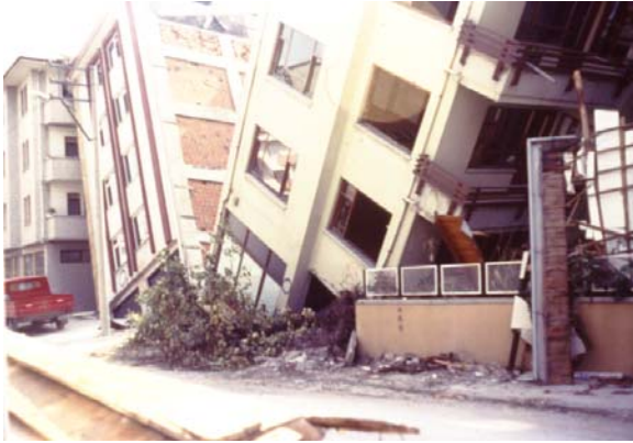
Şekil 4- 17 Ağustos 1999 depreminde Adapazarı'nda sıvılaşma ile hasar gören yapılarda bazıları.
