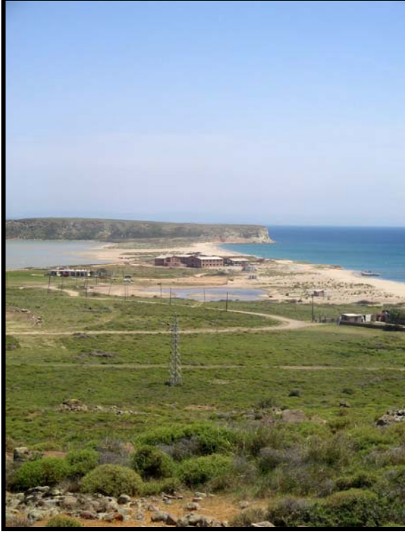
Şekil 13: Tuz Gölü güney kıyı oku üzerindeki turizm tesisleri inşaatı.
