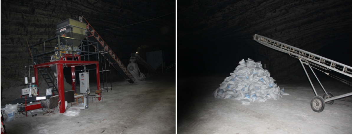
Şekil 3: Tuzluca Tuz üretim tesisinden bir görünüm.
