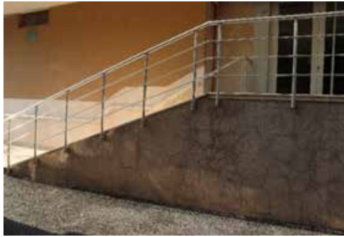
Şekil 12. Açık ortak alan rampa (Kişisel Arşiv)
