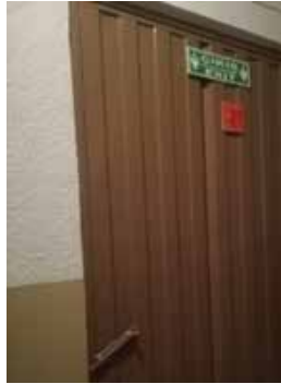
Şekil 18. Yangın merdiveni kapısı (Kişisel Arşiv)
