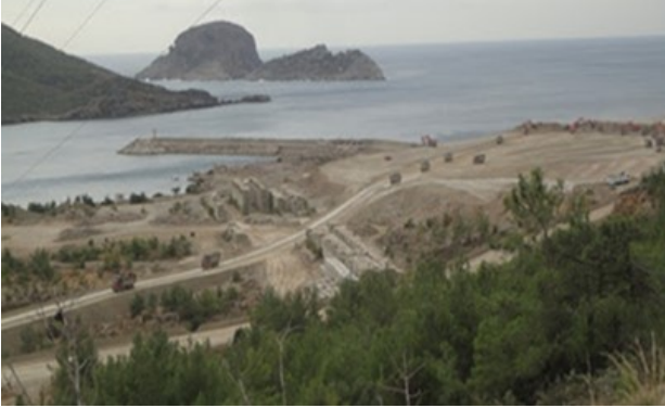
Şekil 2: Akkuyu nükleer santrali inşaat sahası [54].
