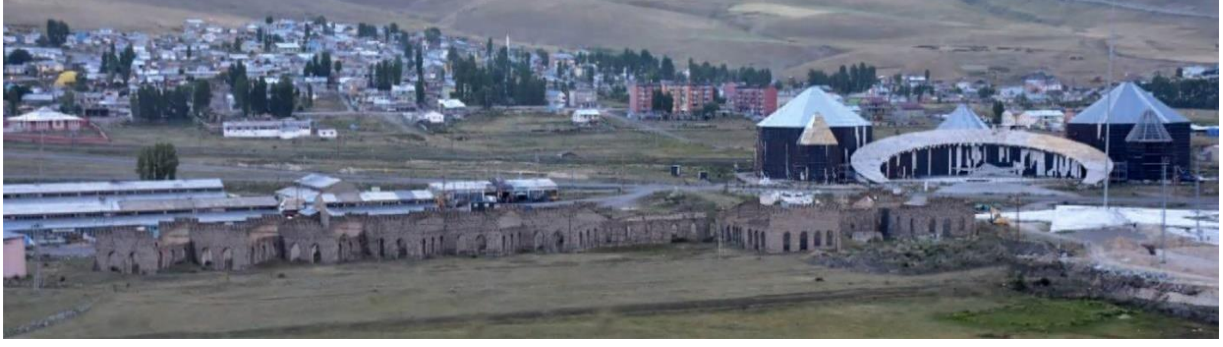
Şekil 5: Revizörlük binası genel görünüm (Doğan, 2019, s. 198)
