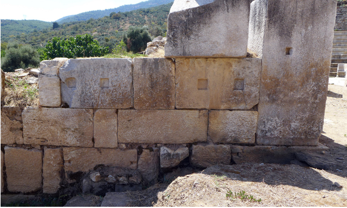
Fig. 7. Skene Doğu Yan Cephe Duvarı ve Spolia Bloklar
