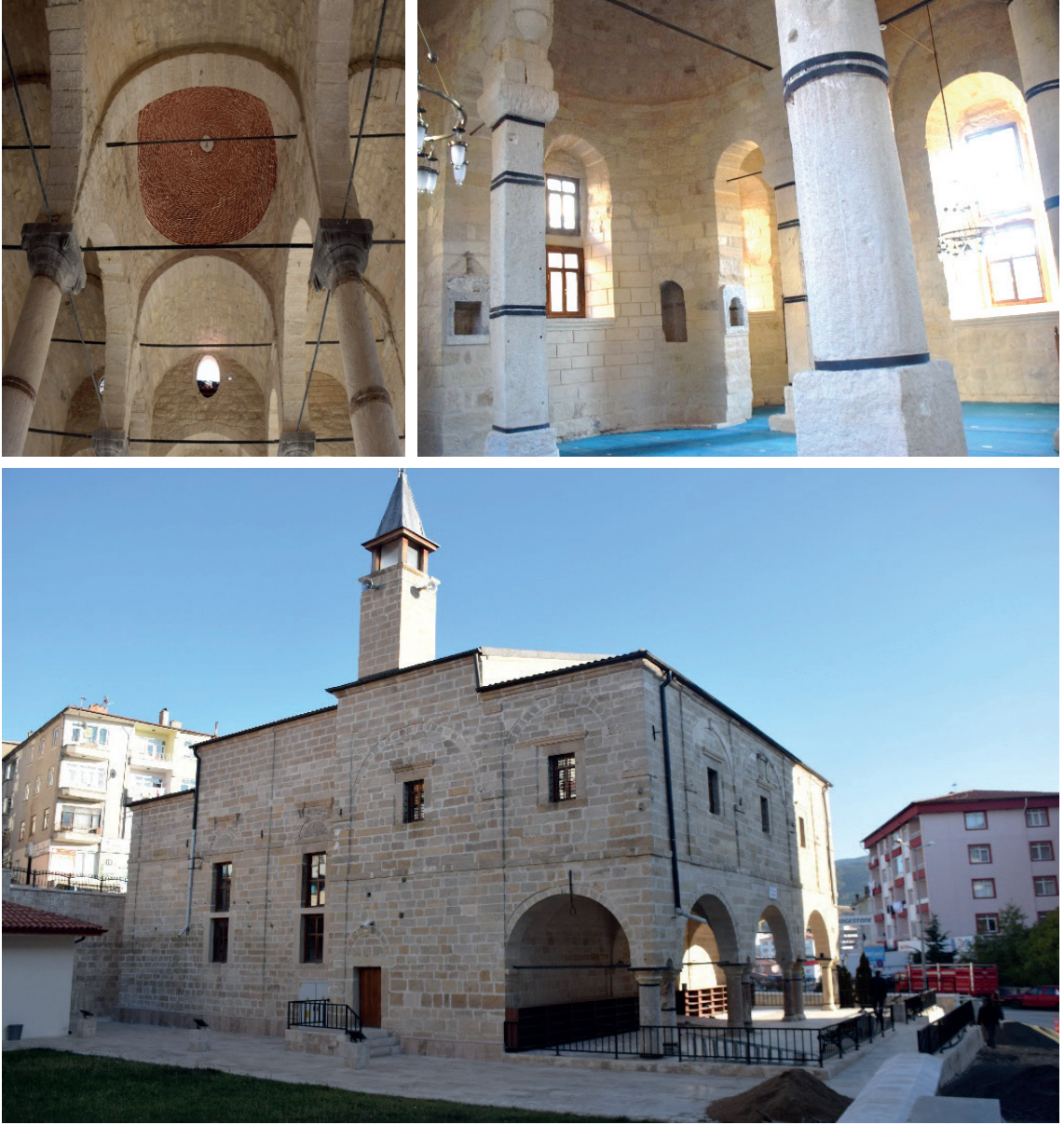
Şekil 20: Yapının Restorasyon Sonrası Durumu (Sivas Vakıflar Bölge Müdürlüğü, 17.11.2020)
