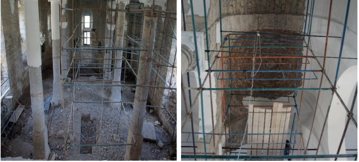
Şekil 17: Restorasyon Sırasında Ortaya Çıkan (a) Vaftiz Havuzu (?) ve (b) Orta Kubbe (2018)
