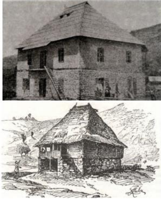
Şekil 11. Vasojevic Tipi Taştan Yapılmış Bir Kule Ev Ve Karma Sistemde Ahşap Ve Taş Malzemeden Yapılmış Dağ Evi (Kapetanović, 2019,s.12).
