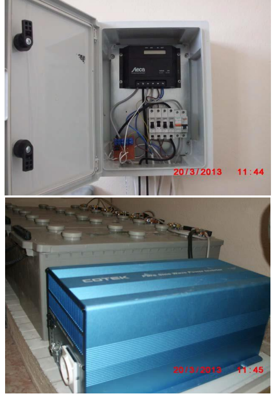
Şekil 3. Şarj ünitesi, sigortalar, akümülatörler ve inverter.
