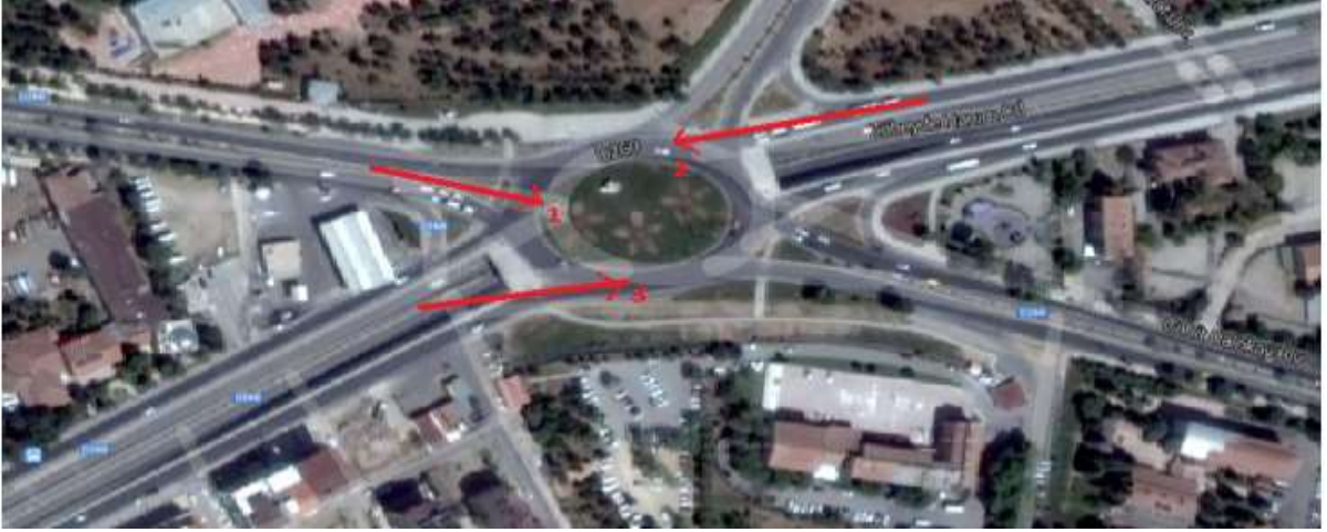
Şekil 6. Çayda Çıra Köprülülük kavşağı
