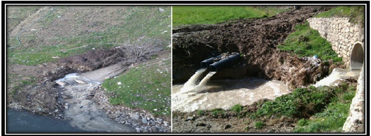
Şekil 8. Eğri Çayı’na arıtılmadan deşarj edilen evsel atıksulardan bir görünüm
