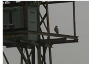
Şekil 4. Elektrik trafosundaki kerkenez
