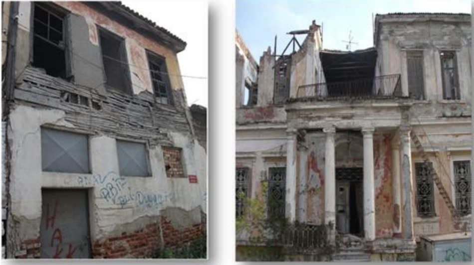
Şekil 8. Ahşap karkas iskelette dağılımlar (eleman bazında bozulmalar)
