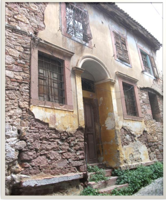
Şekil 6. Zeminden yükselen nemin duvar yüzeyinde buharlaşması sonucu görülen çiçeklenmeler (Yazar arşivi, 2010)
