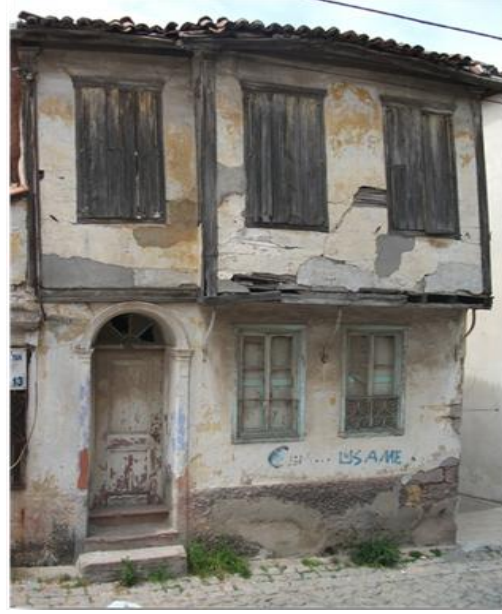
Şekil 6. Zeminden yükselen nemin duvar yüzeyinde buharlaşması sonucu görülen çiçeklenmeler (Yazar arşivi, 2010)
