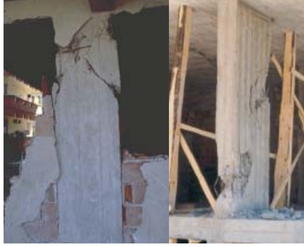
Şekil 2. Kolonda iki adet örnek hasar [18].
