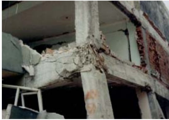
Şekil 7. Kolon-kiriş birleşim yerinde hasar [18].
