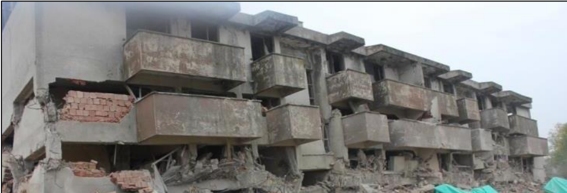
Şekil 15: Binanın Enkazı (Özyurt, 2013)
