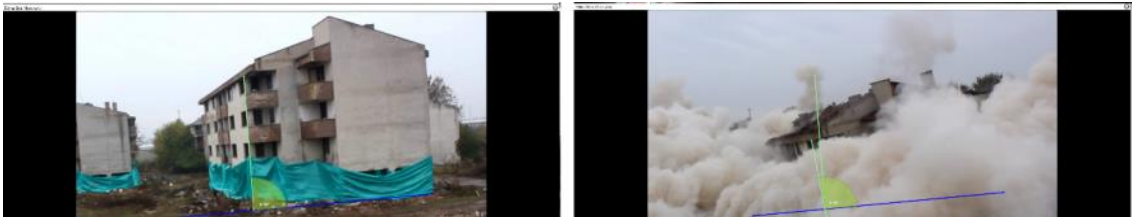
Şekil 19: Patlatma Sonrası Binanın Eğilme Açısı (Özyurt, 2013)
