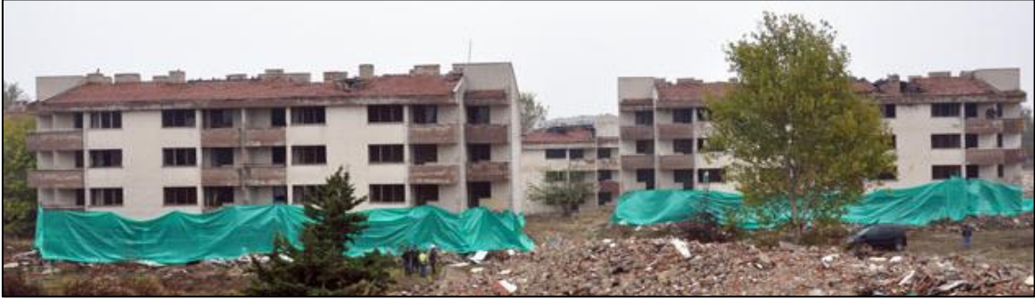
Şekil 14: Binanın Yıkıma Hazır Hali (Özyurt, 2013)
