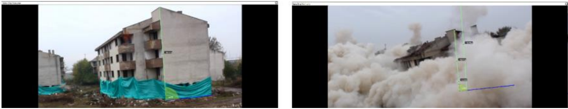
Şekil 18: Patlatma Sonrası Binanın Alçalma Miktarı (Özyurt, 2013)
