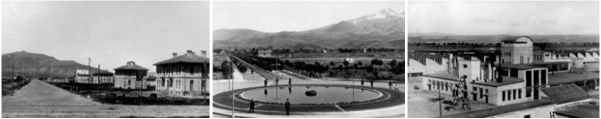
Şekil 3-4-5. Cumhuriyet'in modern mimarlık ikonları, istasyon mahallesi, hastane caddesi ve Sümerbank bez fabrikası, 1935.
