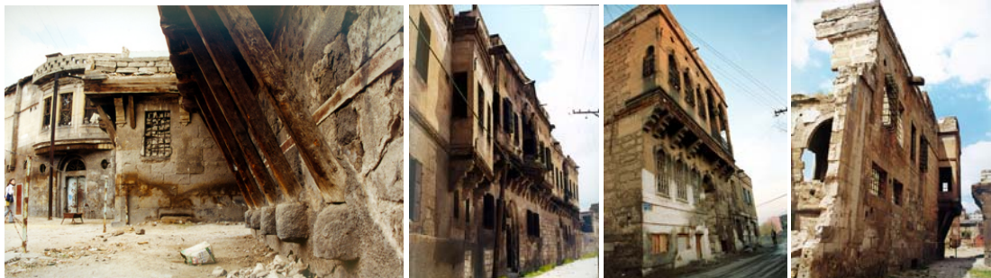
Şekil 6-7-8-9. Kayseri eski kent merkezindeki konutlar.
