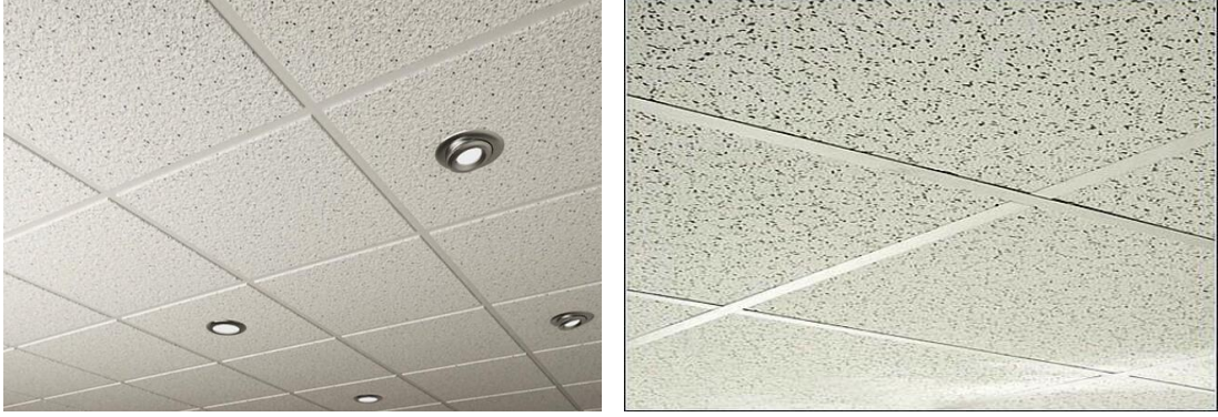
Şekil 3 ve Şekil 4. Camyünü asma tavan (URL 3; URL 4)
