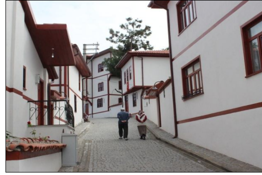
Foto:24 Restorasyonu tamamlanan Tacettinin Pařa Caddesi
