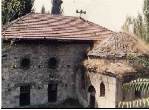
Foto 3: Kurşunlu Camii'nin restorasyon öncesi görünümü (Kaynak, Beşer Kuyumculuk).
