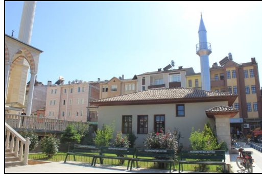
Foto 8: Restorasyonu sonrası (2008) Namazgâh Camii'nin doğudan görünüşü
