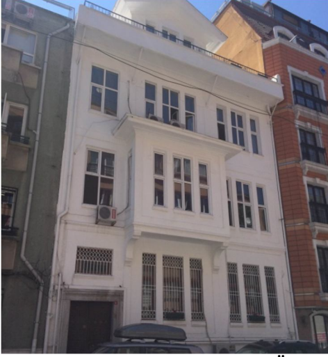
Fotoğraf 6 Selim Bey Konağı Ön Cephe
