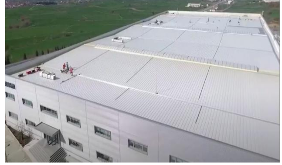
Şekil 10. GES kurulacak çatı görünümü.
