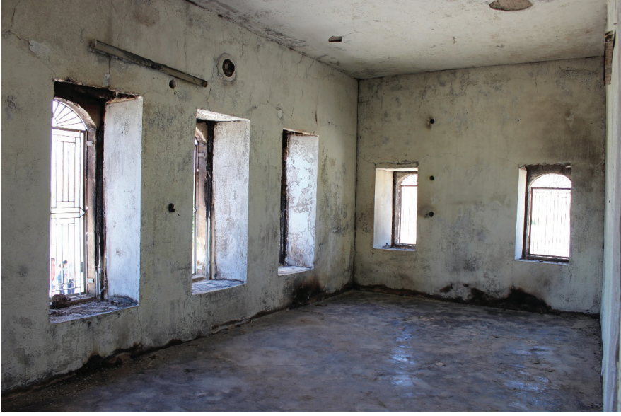
Resim 4: Zemin Kat İç Mekân Kuzey ve Batı Duvarları
