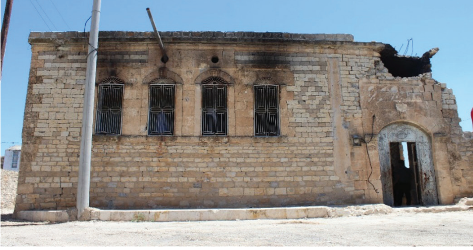
Resim 8: Yapının Batı Cephesi
