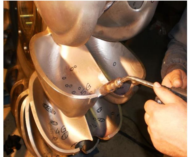
Şekil 12. Çark Kaşıklarında kaynak öncesi ısıtma işlemi
